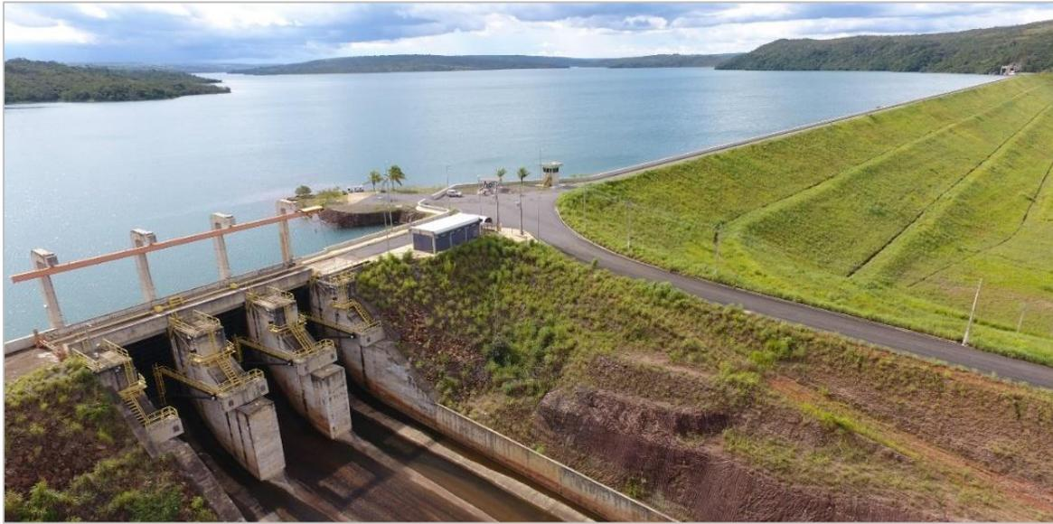
A Barragem da UHE Corumbá IV é formada principalmente de terra e argila, tem comprimento total de 1.290 metros e altura máxima de 76 metros. A largura da barragem chega aos 400 metros na base e aos 10 metros no topo.
