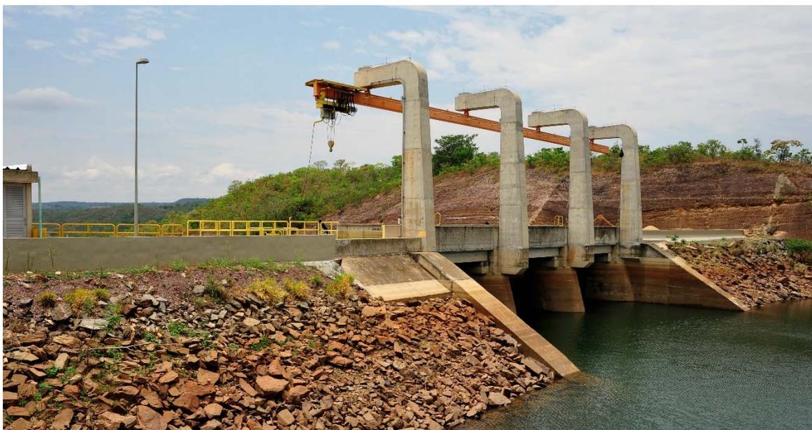
A Casa de Força é composta de duas unidades geradoras com potência instalada de 127 MW. A água do reservatório é direcionada para a Casa de Força e a velocidade desta locomoção movimenta a turbina que, acoplada ao gerador, produz a energia.
